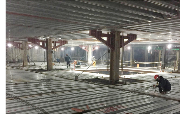
지하깊이 최소화 슬래브지지공법 (Up-Up, Semi-Topdown, Full Topdown)
