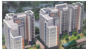
송파 성지아파트 리모델링
