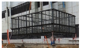
거푸집 양중 및 하부철근에 설치
