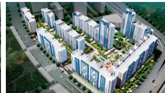
이촌 현대맨션아파트 리모델링
